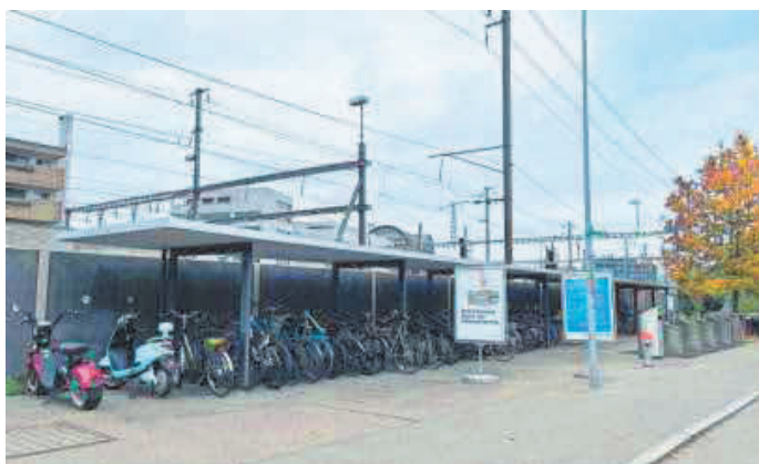
Auch auf der Rückseite des Bahnhofs werden die Veloabstellplätze rege genutzt.
